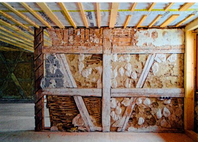
Innenwände aus Fach- und Flechtwerk werden original wieder hergerichtet.
